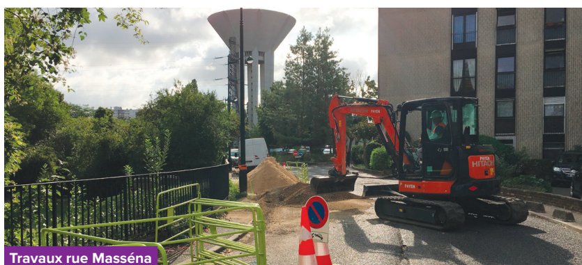
Travaux rue Masséna
