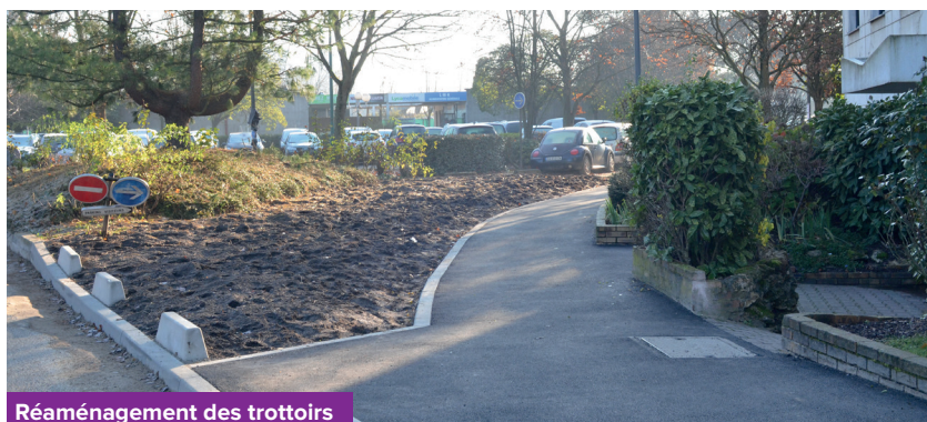
Réaménagement des trottoirs
